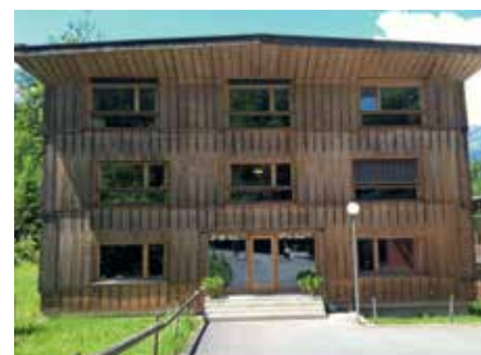
Steht bei uns noch auf der Wunschliste: ein neues Verwaltungsgebäude (natürlich aus natürlichen Baustoffen).
