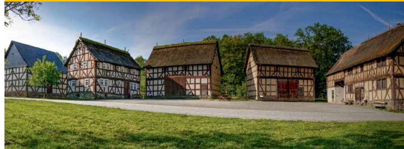
Im Haus Heck (zweites Gebäude von links) wird an einer neuen Dauerausstellung gearbeitet.
