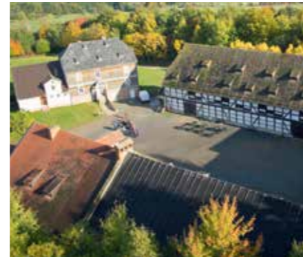
Die Wiedereröffnung des Fruchtspeichers aus Trendelburg ist für Herbst 2019 vorgesehen.
