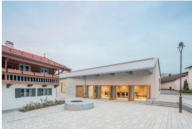
Rathaus Maitenbeth, Deutschland, 2016 / Architektur: meck architekten Foto: Michael Heinrich
