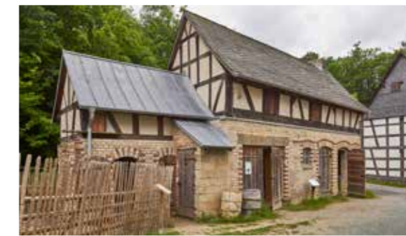
Nebengebäude aus Breitenbach, 2016, Foto: Freilichtmuseum Hessenpark, Norbert Miguletz
