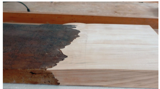
Abb. 5 Ergänzte Bruchkante mittels 3D-Laserscanning und CNC-Fräse (heller Bereich).
