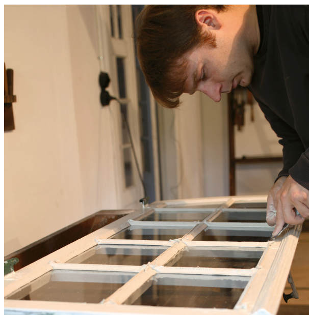
Abb. 2 Sanierung der Werkstattfenster des Restaurierungszentrums, Dipl.-Restaurator Lars Böhner beim Verkitten der historischen Fensterverglasung.
