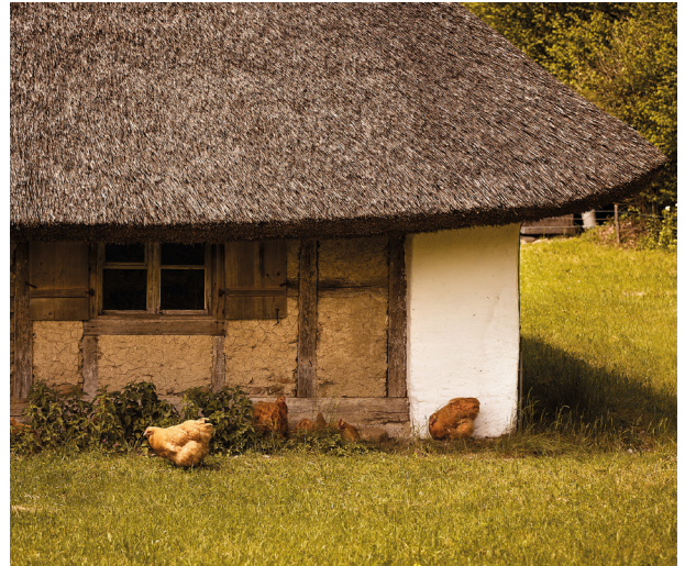
Abb. 2 Ein Ballenberg-Hühnervolk beim Strohdachhaus aus Leutwil AG
